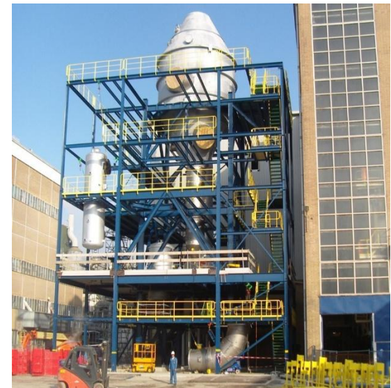
Bestaande MVR-Zout recrystallizer in Delfzijl
